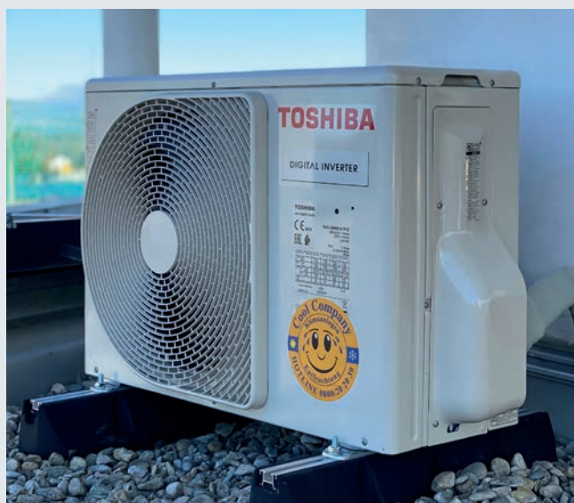
Boom Software AG Leibnitz, Cool Company (chlazení, klimatizace, gastronomie)
